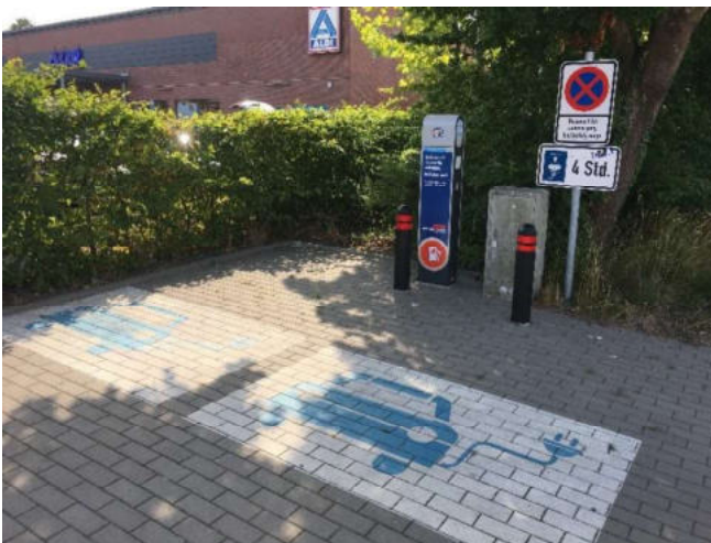
Abbildung 105: Elektro-Ladestation an der Küsterkamp (© ZEBALU GmbH)
