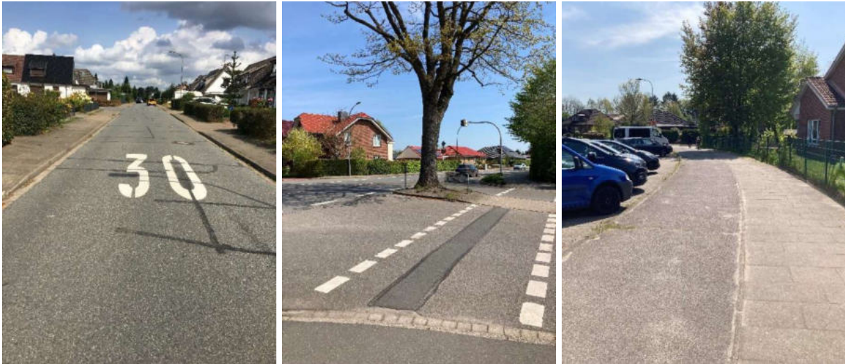
Abbildung 96: Radverkehrsinfrastruktur im Projektgebiet: Radverkehr wird im Mischverkehr geführt (links), gemeinsame Wegführung mit Fußverkehr im Mühlenweg (mittig), getrennter Rad- und Fußweg am Heederbrook (rechts). (Quelle: ZEBAU GmbH)
