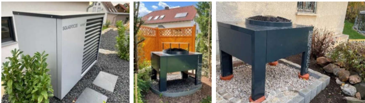
Abbildung 68: Foto Luft-Wasser-Wärmepumpe als Splitgerät (l.) 36 , Foto Referenzprojekte (m. und l.) 37
