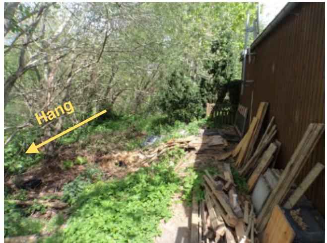
Foto 8: Bauschutt und Sperrmüllablageung an der südlichen Grundstücksgrenze
