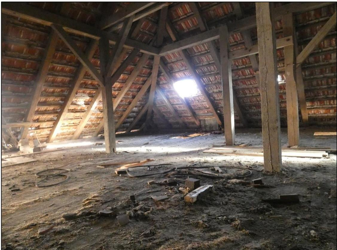
Abbildung 5: Der Dachboden ist durch eindringendes Regenwasser an mehreren Stellen einsturzgefährdet.
