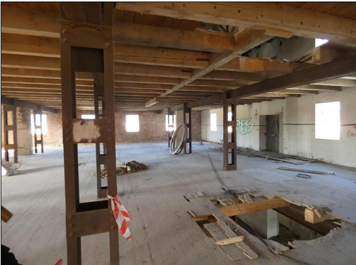
Abbildung 3: Selbst im 1. Stockwerk zeigen sich schon Deckendurchbrüche.
