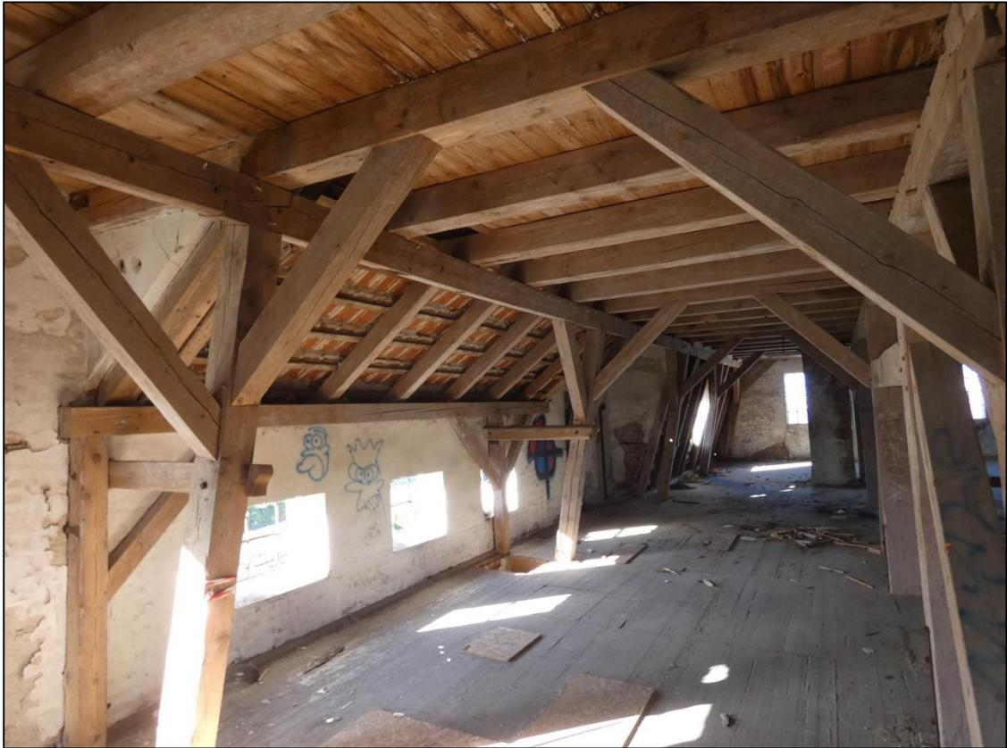
Abbildung 4: Oberstes Geschoss. Das Dach ist nur einfach eingedeckt, die Böden einfach beplankt.
