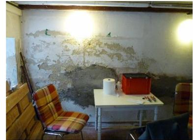
Abb. 155: Schäden durch Feuchtigkeit im Kellergeschoss, Ostwand. *complan Kommunalberatung*
