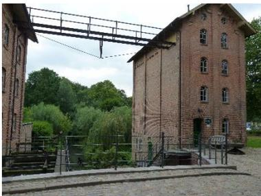
Abb. 159: am Mühlenspeicher ist eine Art Brücke zum Transport von Mahlgut erhalten.
