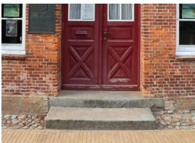
Abb. 153: mangelnde Barrierefreiheit: Zwei Stufen führen zum Eingang des ehem. Amtsgerichts. *complan Kommunalberatung*
