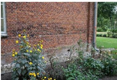
Abb. 152: Bauschäden durch Feuchte. Detail des Gebäudesockels an der Nordostecke. *complan Kommunalberatung*
