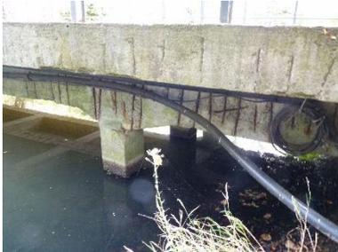
Abb. 128: schwere Bauschäden an der Inselbrücke. Blick von der Nordostseite. *complan Kommunalberatung*
