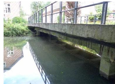
Abb. 145: Bauschäden an der Inselbrücke. *complan Kommunalberatung*
