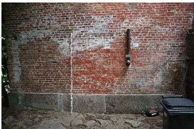
Abb. 48: aufsteigende Nässe im Sockel der nördlichen Giebelwand. *complan Kommunalberatung*
