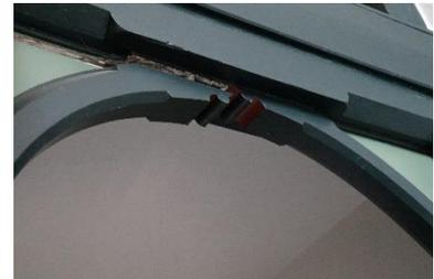
Abb. 53: Beschädigte Balkenköpfe im EG. complan Kommunalberatung
