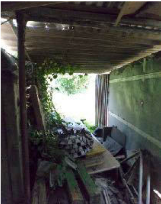
Foto 7: Blick nach Norden durch den Schuppenanbau an der östlichen Grundstücksgrenze
