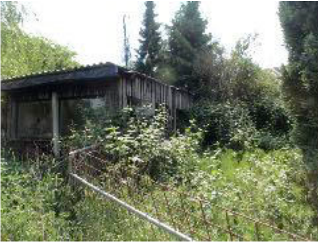
Foto 1: Blick auf den Anbau im „Garten“
