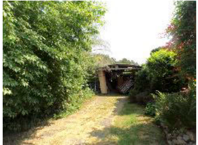
Foto 6: Blick nach Osten auf einen weiteren einfachen Schuppen
