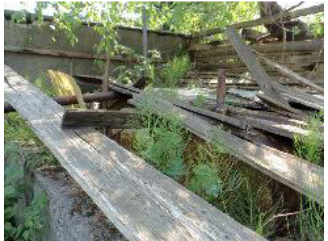
Foto 3b: HEL-Tanks mit Resten des Dachs, Detail.
