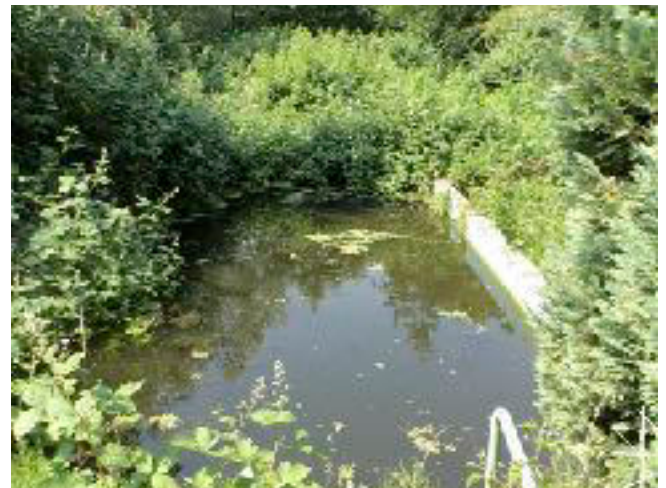
Foto 8: Blick nach Westen über das Schwimmbecken
