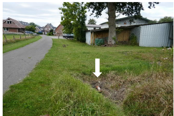
Übergang des Grabens in eine Verrohrung
