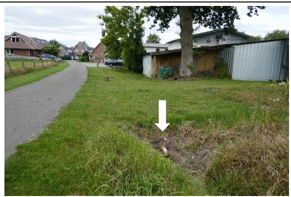
Übergang des Grabens in eine Verrohrung
